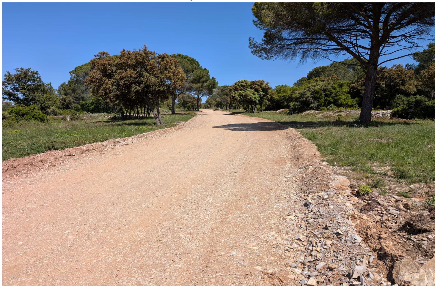
Piste DFCI B107 après travaux de mise en conformité
