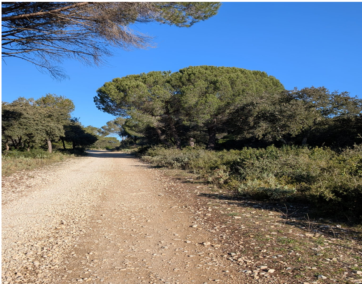
Piste DFCI B107 avant travaux de mise en conformité
